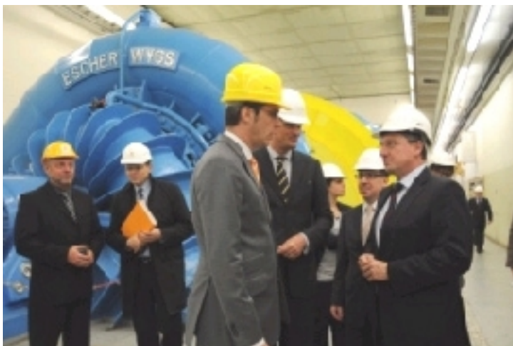
Jost de Jager und Markus Matthießen bei der Wiederinbetriebnahme des Pumpspeicherkraftwerks
